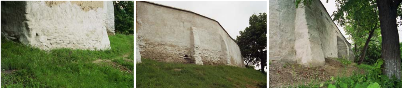
Fundament und Untermauerung
