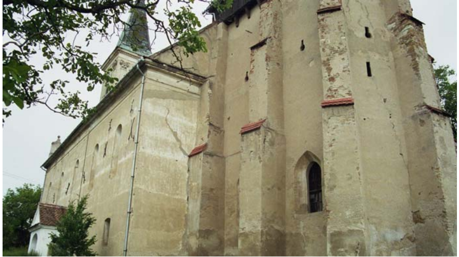
Abdeckung Stützpfiler am Chor mit neuen Dachplatten
